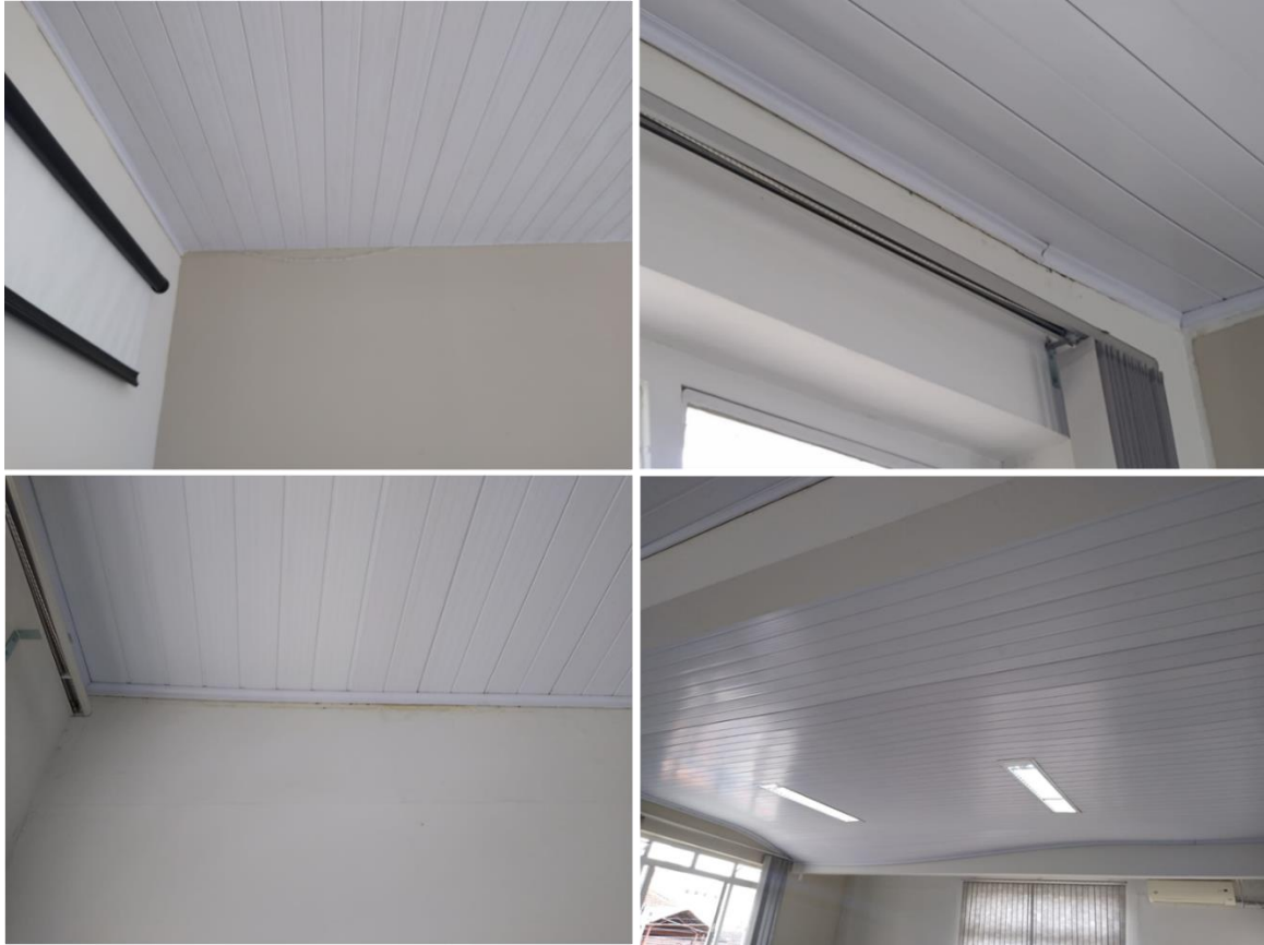
Figura 2-2 – Forro de PVC e Molduras da Edificação 1
